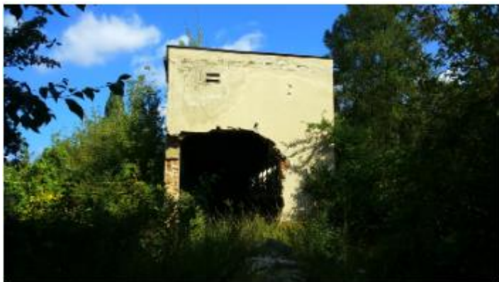
Prace – zbytky ČS
